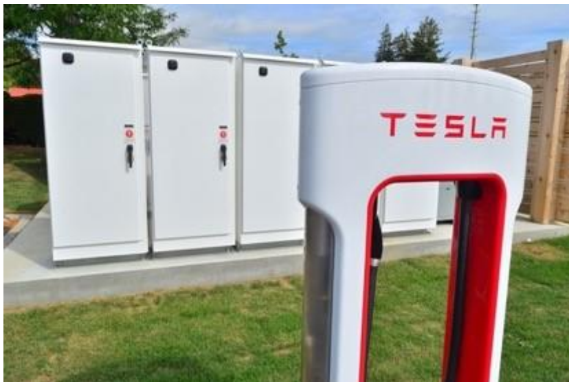
テスラの EV 用スーパーチャージャーと併設されている Powerpack
