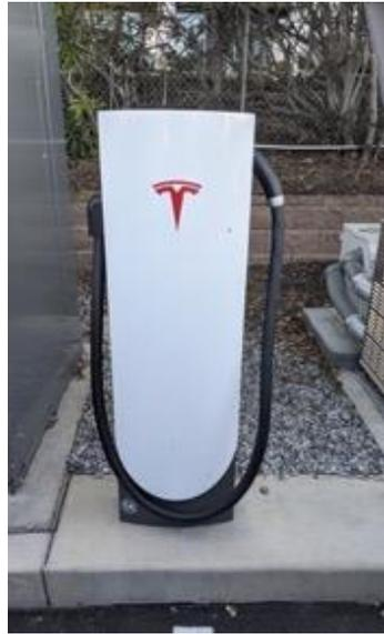
使い方は簡単で、EV の充電ポートにプラグを近づけるか、充電ポートを手で軽く押すか、アプリか車の本体画面で「Open port」というボタンを押すとポートが開く。プラグを差し込むだけで充電が始まる。充電を止める時はプラグのボタンを押すことでプラグがリリースされ、それを抜き取って、走り去るだけである。EV との交信は自動的に行われ、課金はEV のアカウントに登録されているクレジットカードから引き落とされる。これ以上シンプルにはできないというぐらいの垂直統合インテグレーションである。
