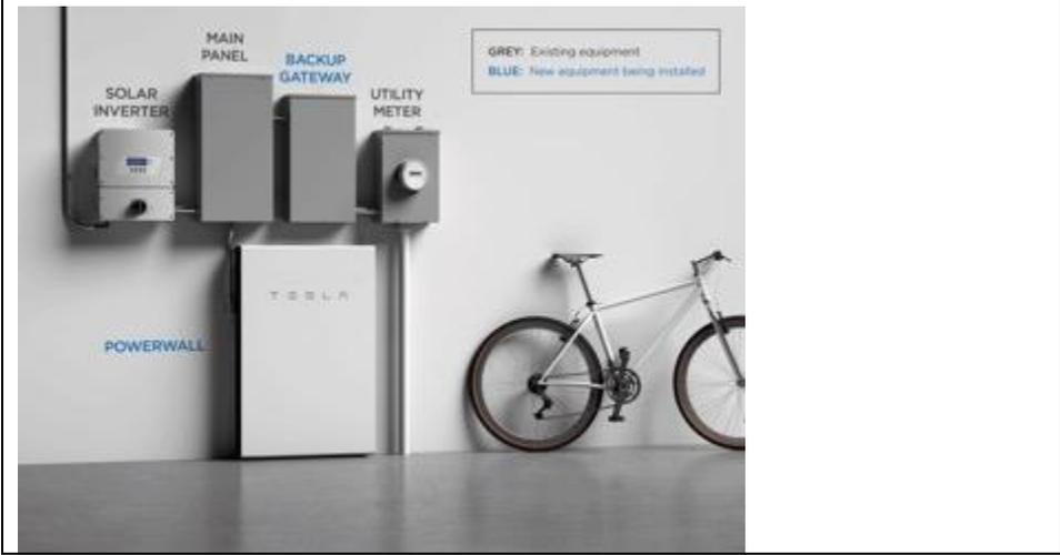
Powerwall 周りの機材の垂直統合もさらに進んだ。新しい Powerwall+ はそれまでは別々だったソーラーパネルとの接続に使うゲートウェイ（配電盤）とインバーターをバッテリーと一体化させた。これによって Powerwall+、Tesla Backup Gateway と Tesla Inverter が物理的にも統合された。
