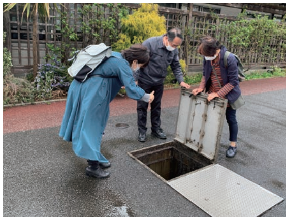
写真 1-2-4 駐車場下に設けられた雨水貯留槽。 橋本淳司撮影
