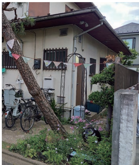
写真 1-2-3 個人宅の庭の一角に設置された「雨庭」。中央の豎樋からの雨はアーチを經由して地下30cm程に設けられた礫層に一旦貯留され、さらに下にゆっくり浸み込む。東京都世田谷区、筆者撮影
