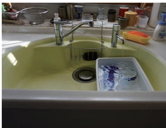
写真 1-2-6 台所の雨水水栓。筆者撮影
