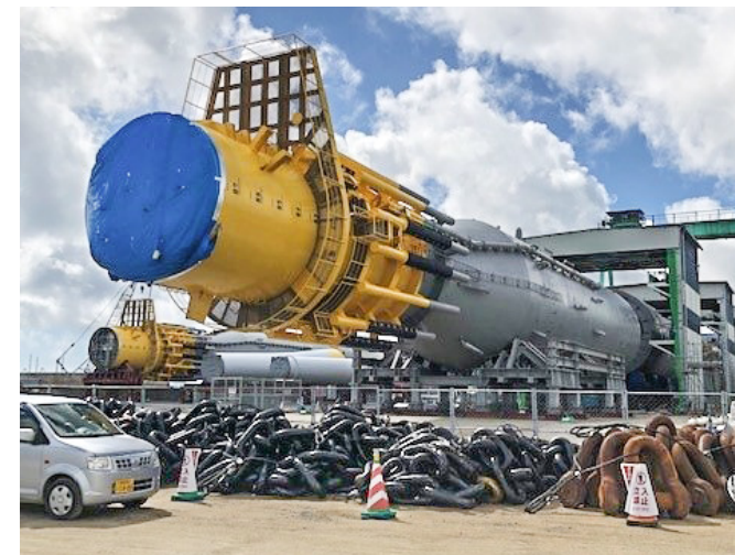
2022年8月筆者撮影 ヤードで建造中のハイブリッドスパー型浮体
