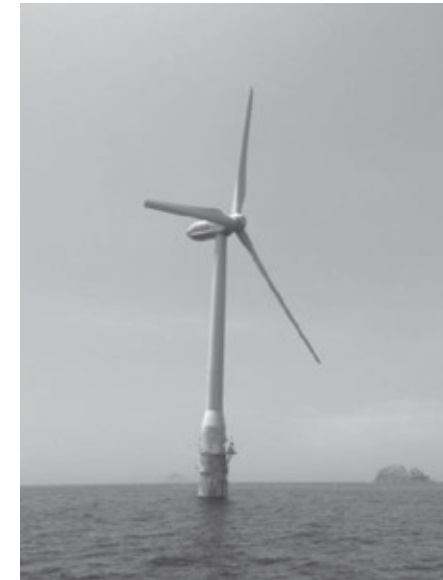
図表 22：浮体式洋上風力発電「はえんかぜ」
