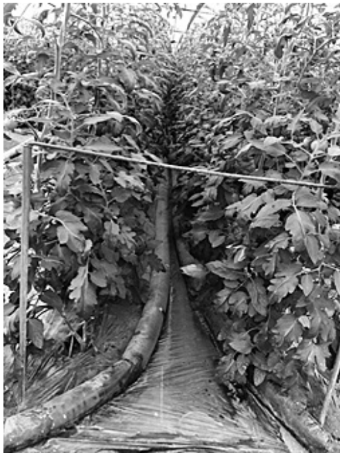
図表 32： トマトを栽培する地熱水利用園芸ハウスに敷き込まれた温水を回しているビニールチューブ
