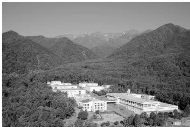
図表2 駒ヶ根工場
